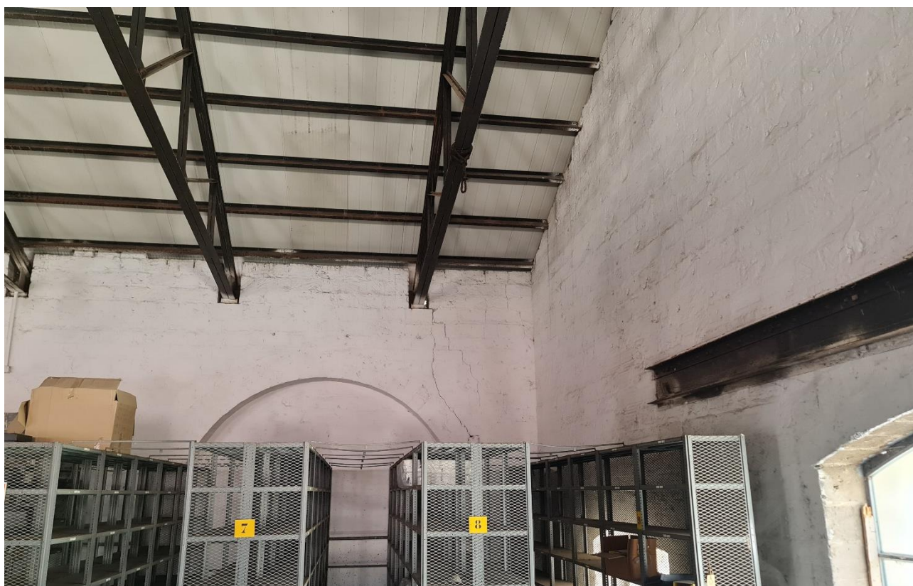
Figura 29 - Fessurazioni in corrispondenza degli appoggi delle capriate
