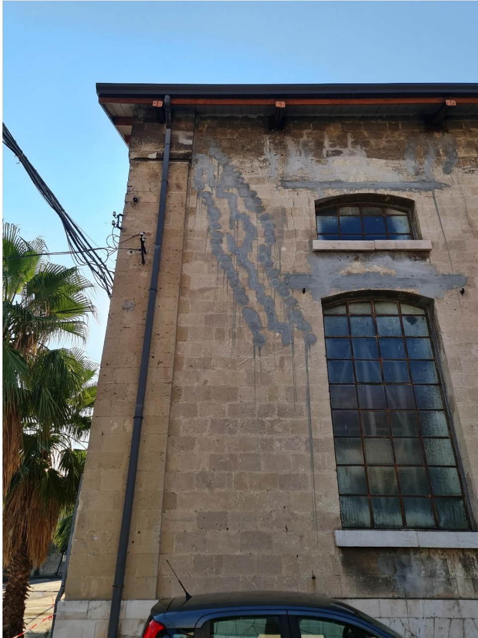
Figura 31 - Interventi di chiodatura presenti sul prospetto Ovest
