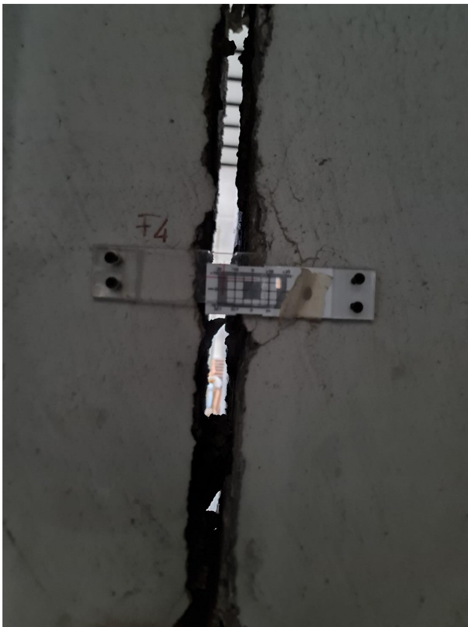
Figura 24 - Lesione muratura Ovest, particolare
