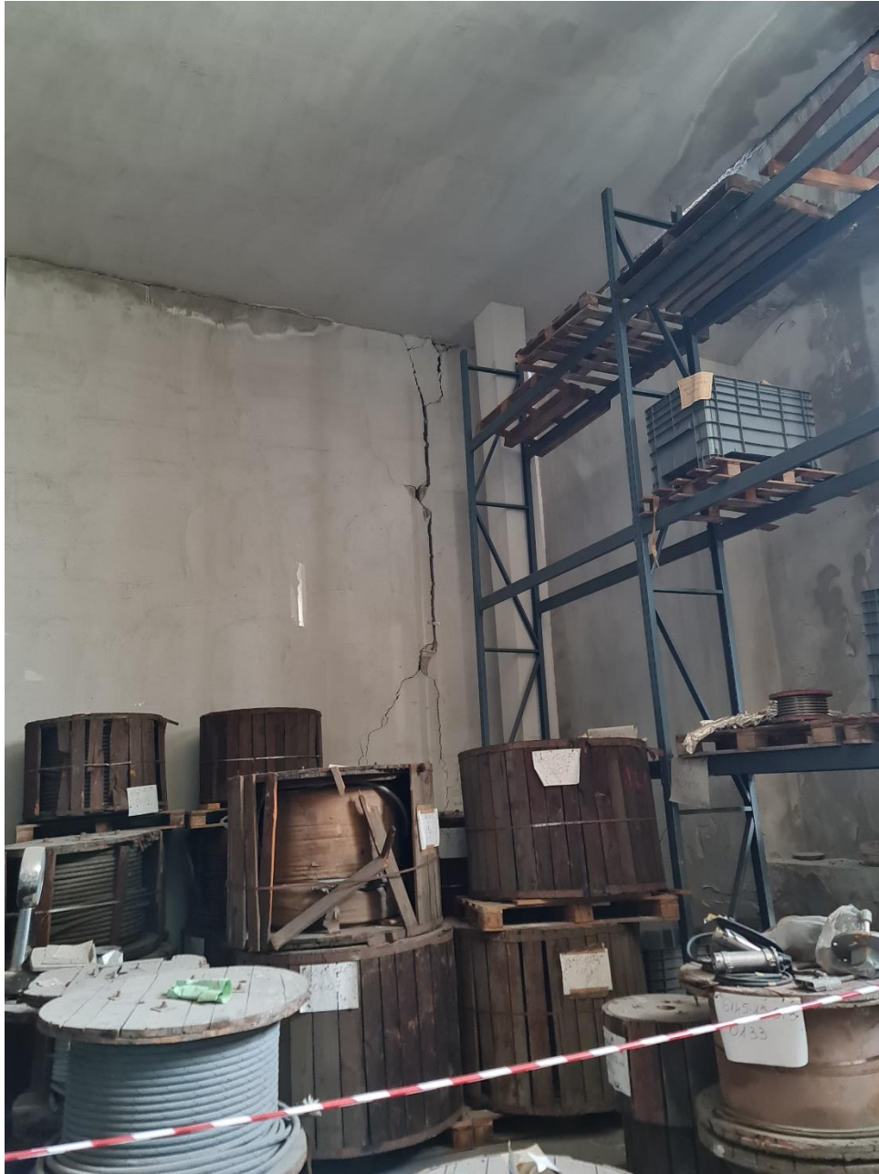
Figura 23 - Lesione muratura Ovest
