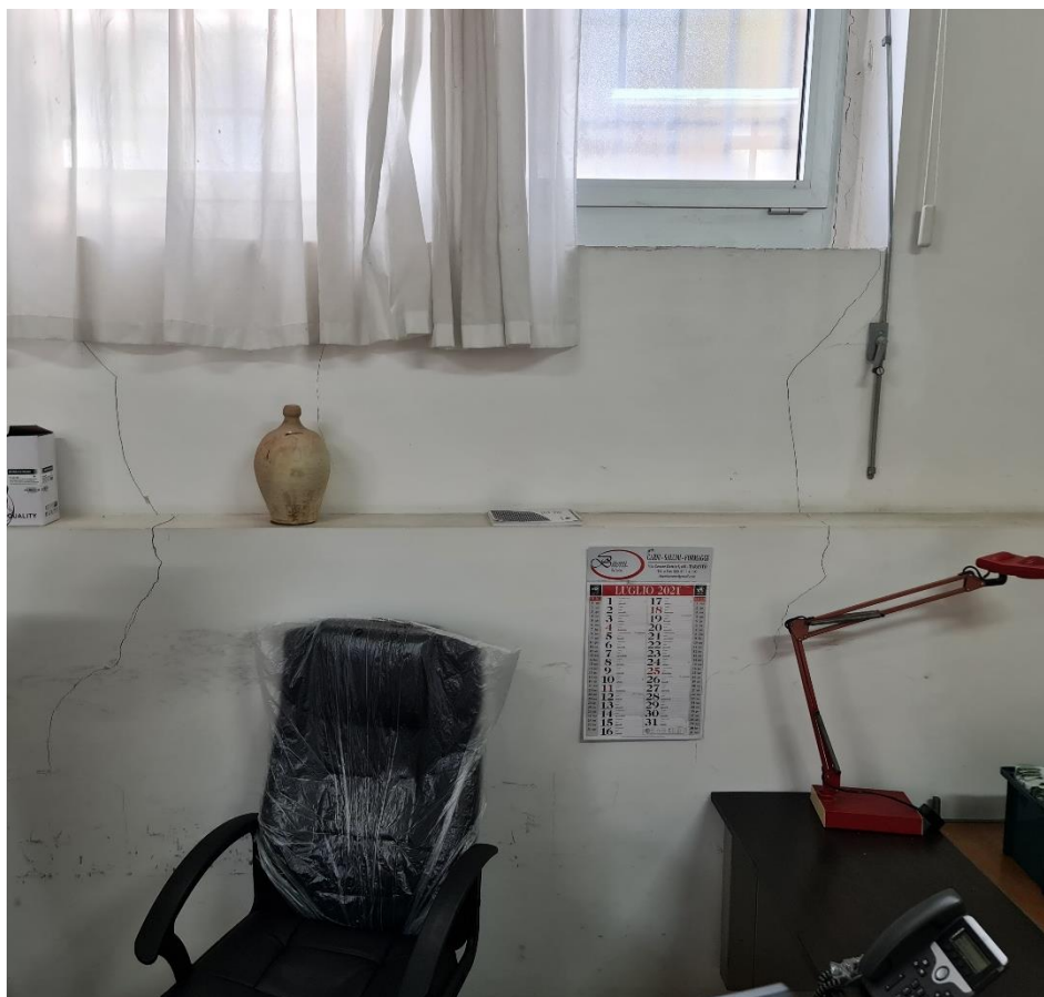
Figura 16 – Lesioni in corrispondenza di un infisso presente sulla facciata Est
