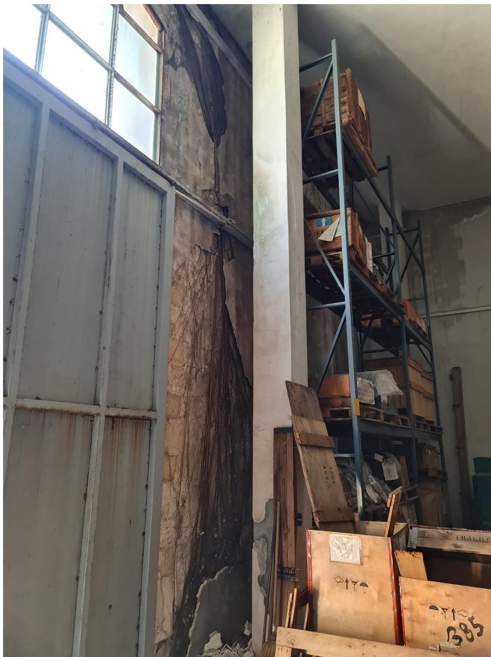
Figura 22 - criticità imputabili ad una carenza di regimentazione dell'acqua piovana
