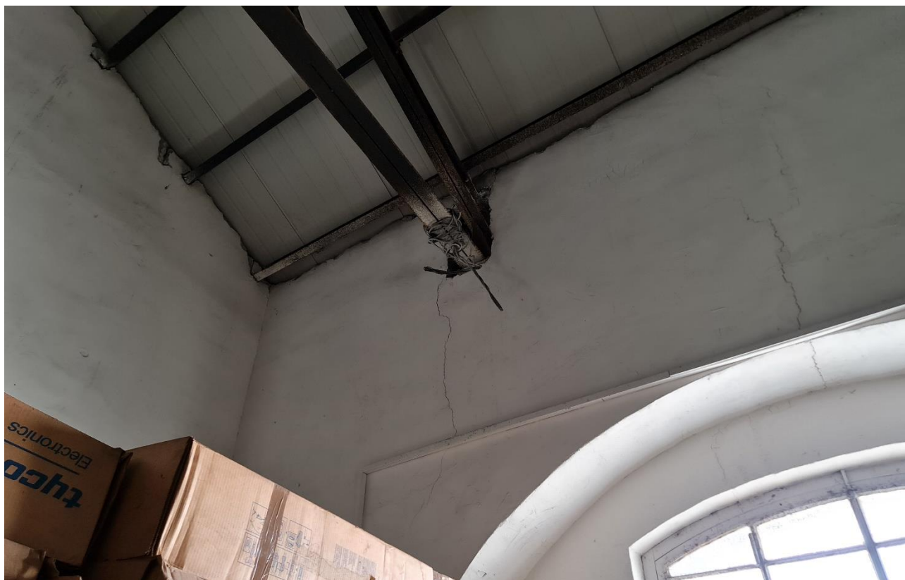
Figura 28 - Fessurazioni in corrispondenza degli appoggi delle capriate
