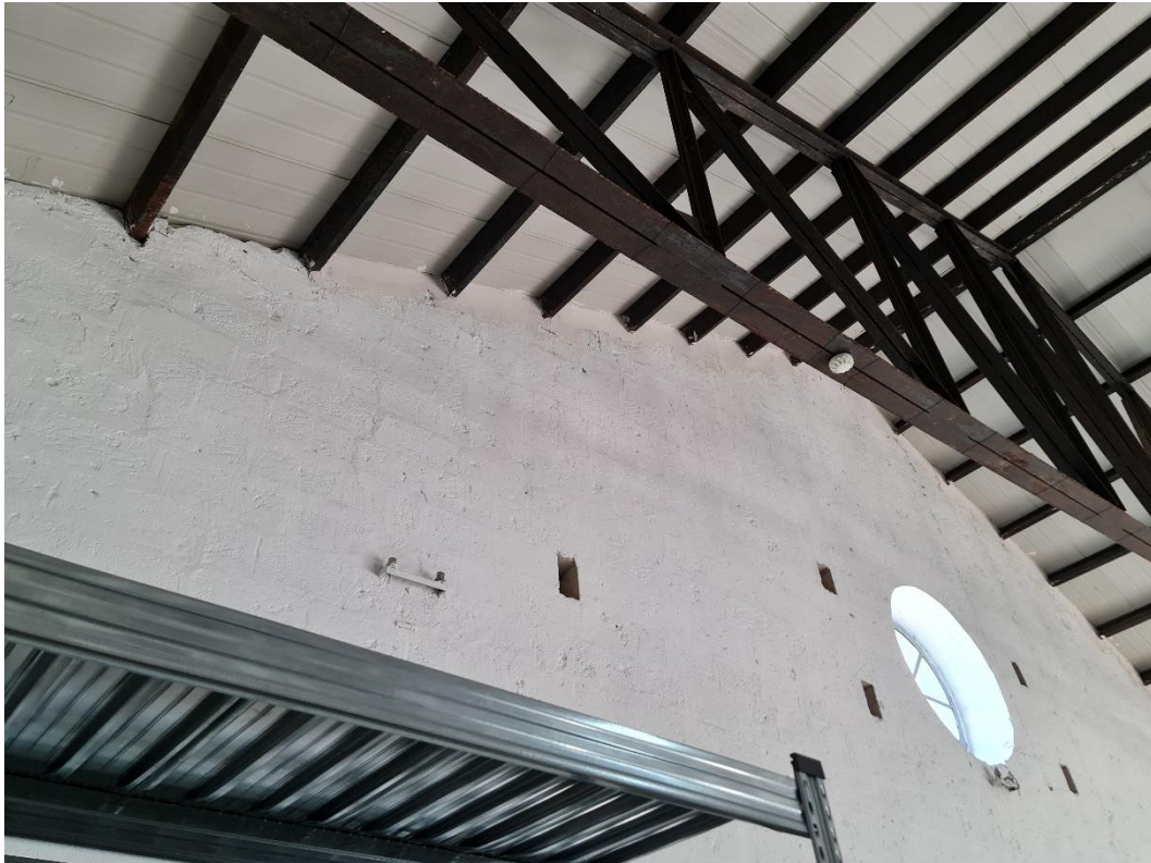
Figura 12 - Alloggi arcarecci
