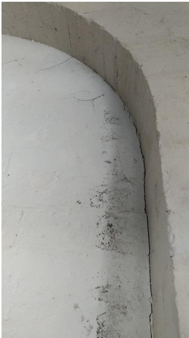
Figura 15 – Lesione parete in comune tra magazzino D40A e D39A
