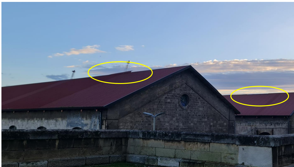
Figura 32 - Criticità lamiera di colmo
