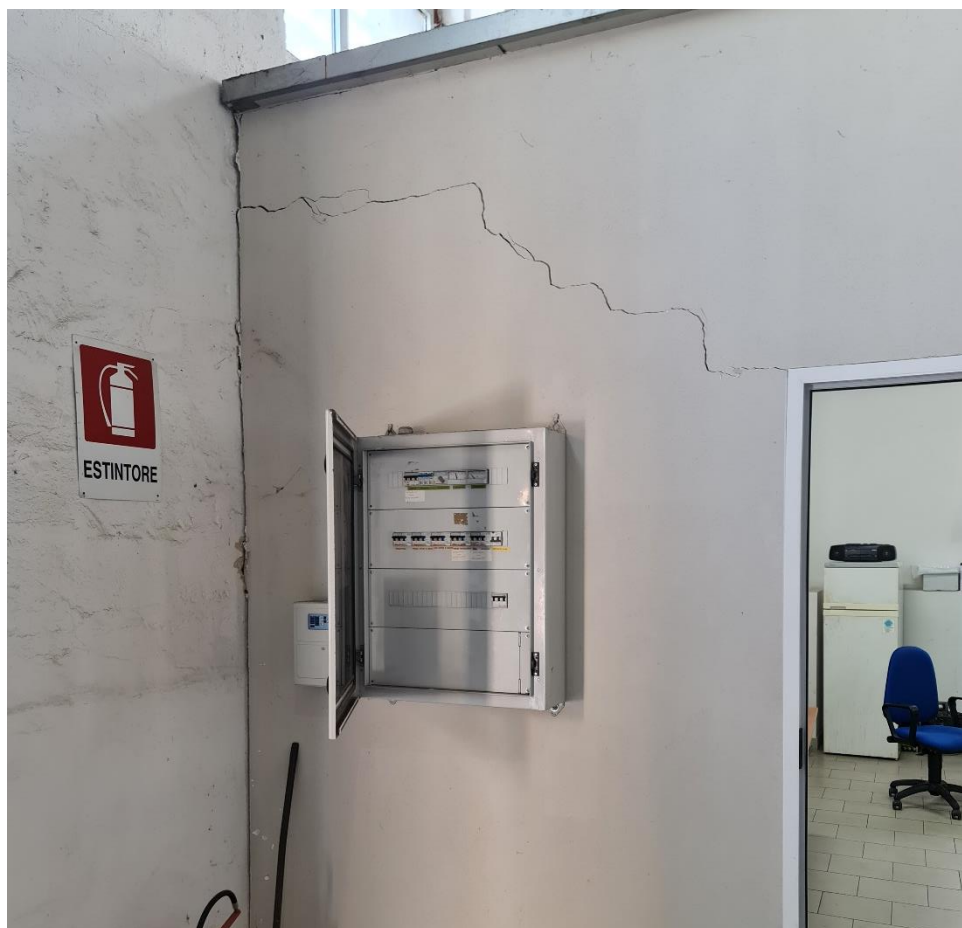
Figura 13 - Lesioni parete divisoria, vista lato magazzino
