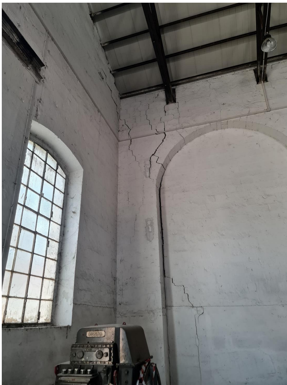
Figura 30 - Lesione passante sulla muratura divisoria con magazzino D39A
