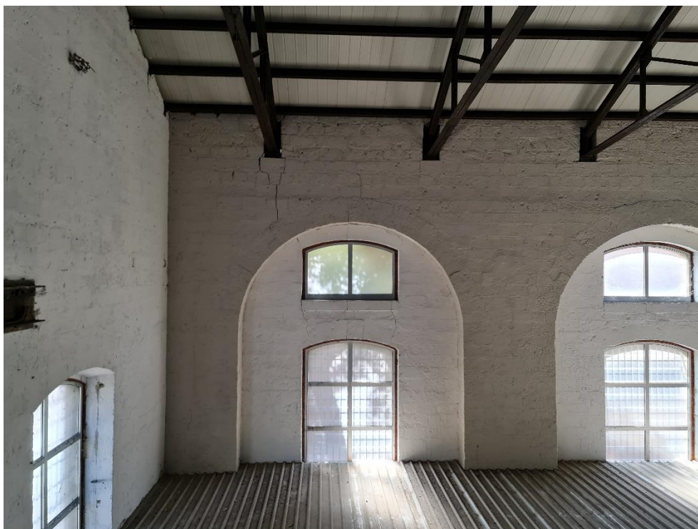
Figura 10 - Lesioni sub-verticali angolo Nord-Est
