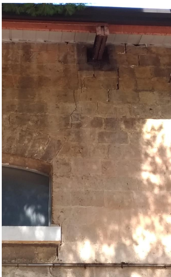
Figura 10 - Lesioni sub-verticali angolo Nord-Est
